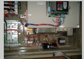
定格主電動機からインバータ電動機に変更
