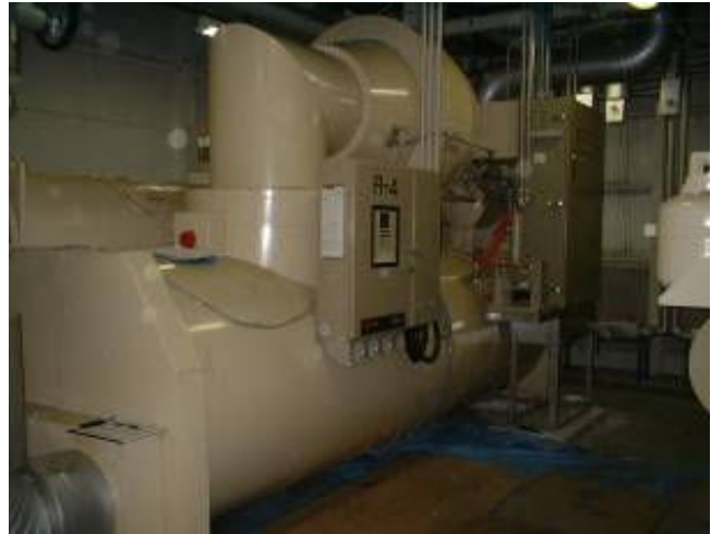
定格主電動機からインバータ電動機に変更
