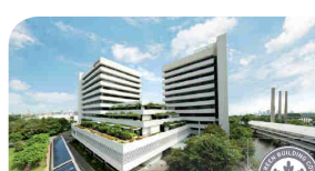
SCG Head Office Building 1, 2, and 5 LEED ระดับแพลตตินัม ประเภทอาคารเดิม ปี 2012
