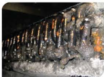
คอยล์เย็นในระบบปรับอากาศที่มีไบโอฟิล์มจับหนาแน่น
