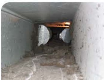
สภาพภายในห้องลมเย็นที่เต็มไปด้วยฝุ่นและเชื้อรา
